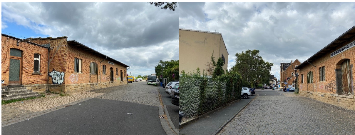
Blick in die Berliner Straße (Güterhalle) und das Plangrundstück (Bild rechts)
