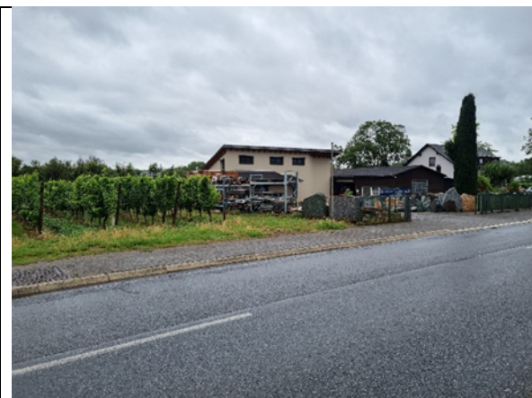
Foto 7: Bebauung an der Südseite der B 42 a Grabmalhändler
